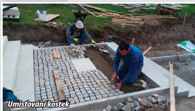
Pokládání kamenných bloků
