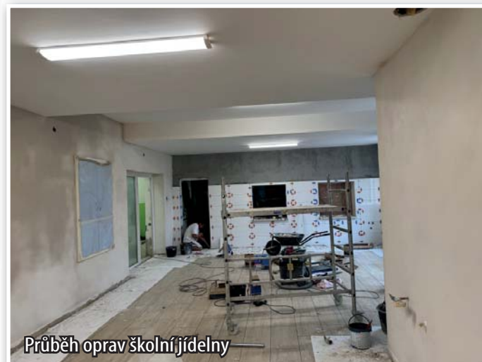
Zahájení oprav ve školní jídelně
