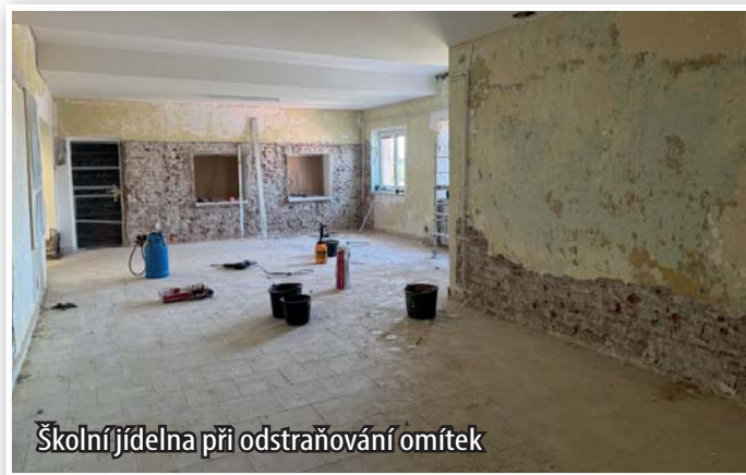
Průběh oprav školní jídelny
