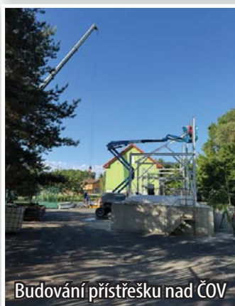
Budování přístřešku nad ČOV
