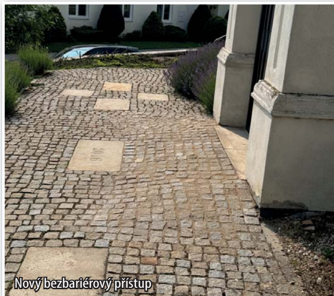
Budování bezbariérového přístupu
