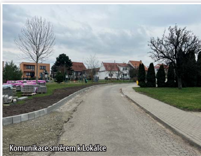
Komunikace s novými obrubníky
