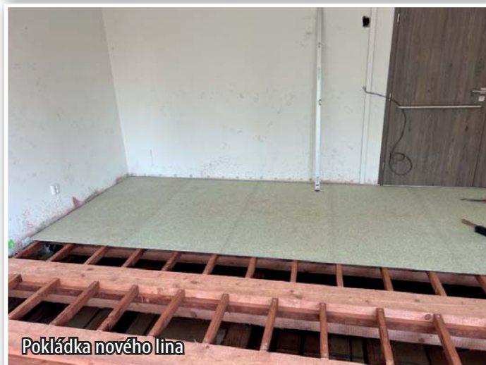
Práce na nové podlaze
