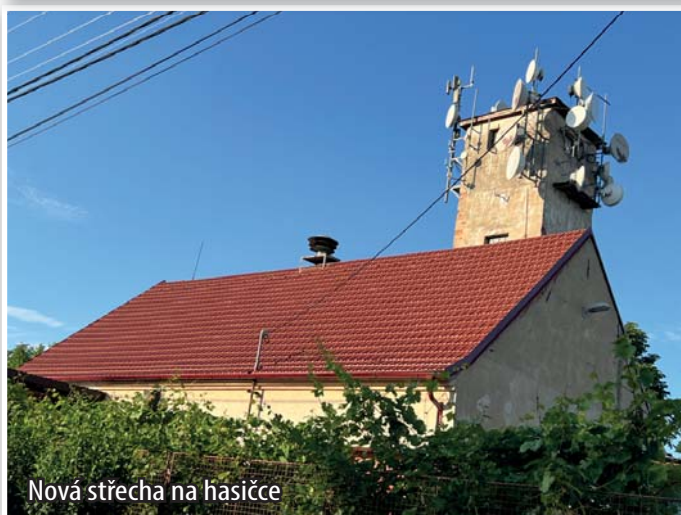
Oprava střechy na hasičce
